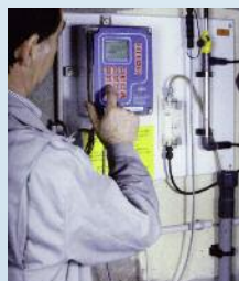
Mise en service
