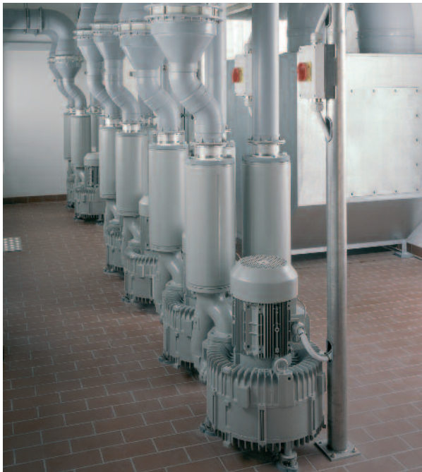
Installation de Bale : station de compresseurs avec filtre à air
